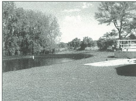
Lagunage : pour compléter le traitement avant rejet dans la rivière
